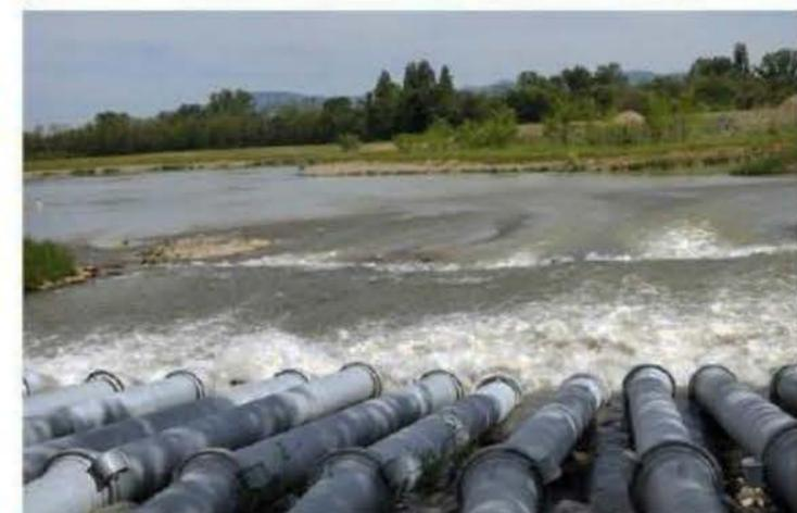
De 2015 à 2016, avant la mise en route de la centrale K, la zone de renaturation était alimentée par l'eau du Canal d'Alsace, grâce à ces tuyaux. Photo archives J.-L.N.
