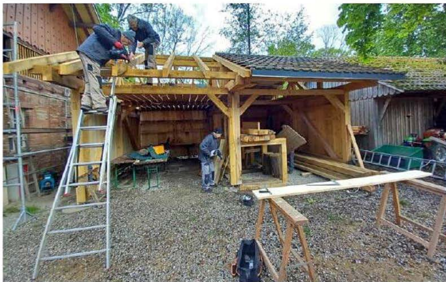
Le groupe de bénévoles des Bras cassés de la Petite Camargue alsacienne est en train de finaliser les travaux de construction d'un hangar pour le stockage du bois. Photo S.Sp.
